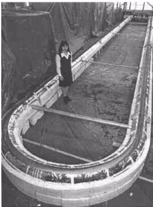
图 1 日本东京电力公司 50 m 长、2 kV 的高温超导电缆
